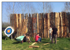
Aprile 2018: lavori di manutenzione e riparazione della palizzata.
